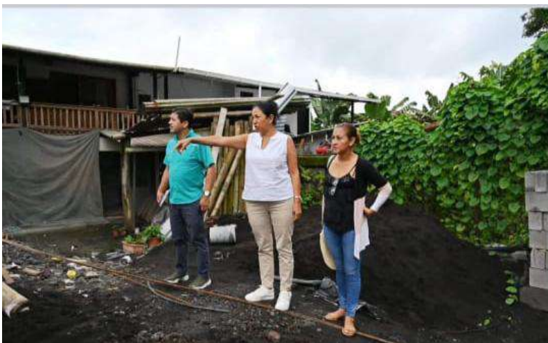
FOTOGRAFÍA 14; REUDECUACIÓN DEL INFOCENTRO BELLAVISTA.
